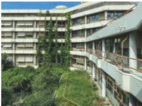
Abbildung 1: Ansicht der Außenfassade der Kopfklinik
