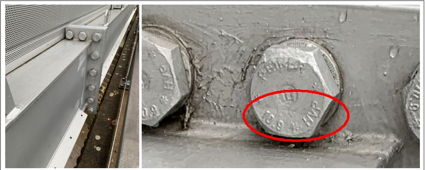
Abb. 2: Einsatz von HVP-Schrauben bei einem Stirnplattenstoß
